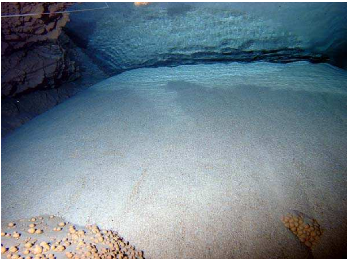
Talus de sable jouxtant le plafond.
